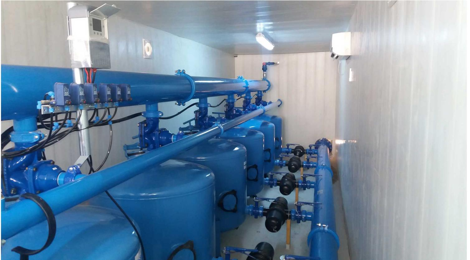
En esta ocasión, **Hidroglobal** ha suministrado una estación de filtración de anillas y arena contenerizada, con un caudal de 50 l/s, para la reutilización de aguas residuales destinadas al riego de 500 hectáreas de olivos. Este tipo de instalaciones son una solución idónea debido a sus diversas ventajas como por ejemplo:
